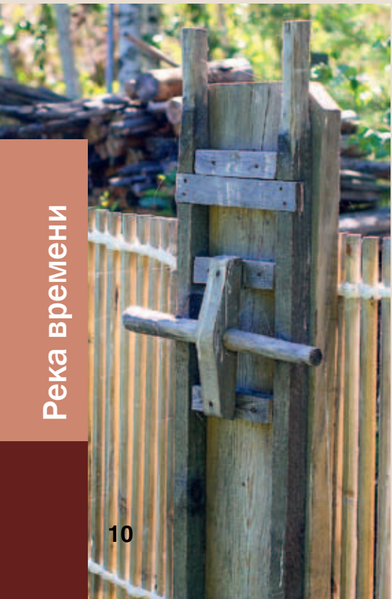
◀ Элемент запора, сомутная рама
